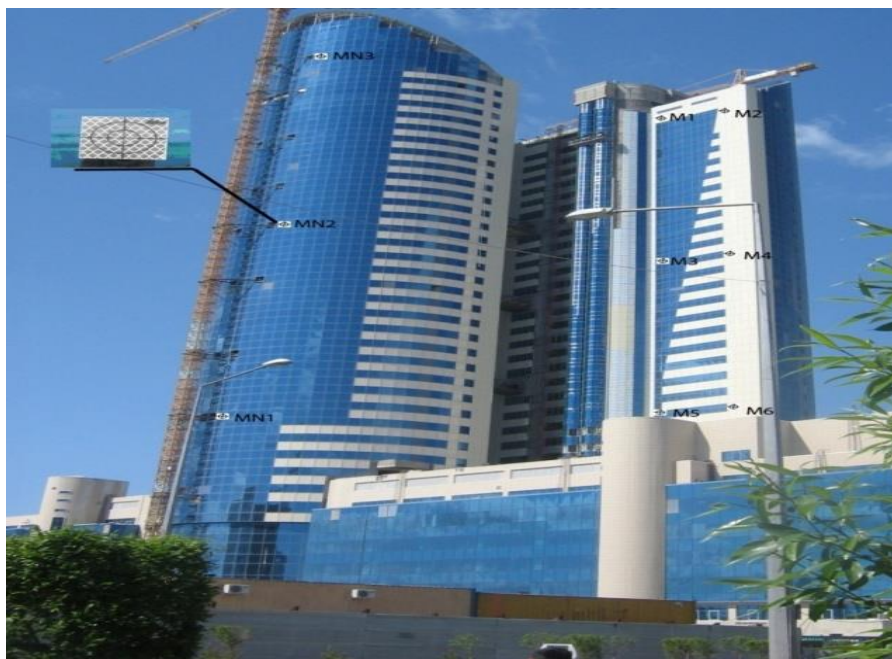
3.3- сурет – Ғимараттағы бақылау маркаларының орналасуы
