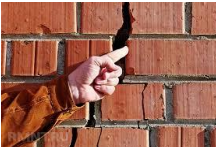
3.2-сурет – Инженерлік құрылыстар деформациялануының әсерінен пайда болған жарықшақтар
