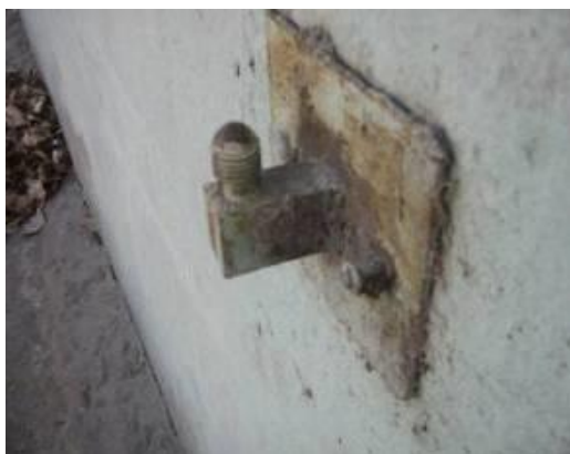
3.4-сурет – Мониторингтік призма және шөгу маркасы
