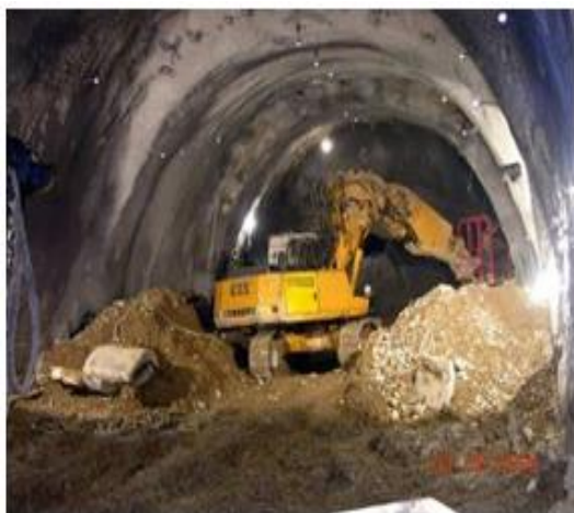
1.6-сурет – Liebherr R932 экскаваторы және «Meuso Suprima» машинасы
